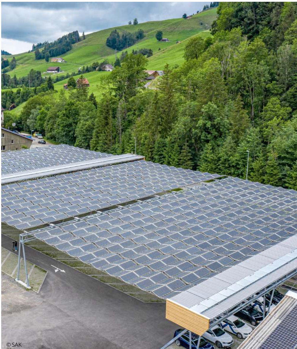
Ein Solarfaltdach spendet nicht nur Schatten, sondern erzeugt auch Strom.
