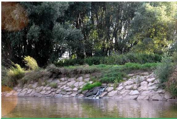
Uferverbauung an der March mit großen Steinen.
