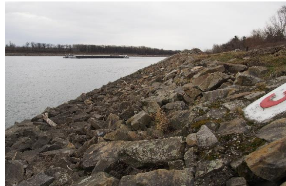
Typische Steine zur Befestigung des Flussufers
