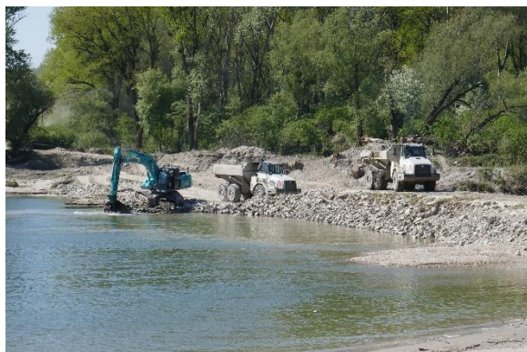
Die Donau wird hier von den Wasserbausteinen befreit
