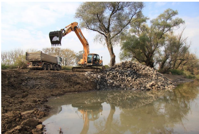
Abbildung 6: Entfernung eines Leitwerkes im Rahmen des bereits umgesetzten Projektes LIFE+ Untere March-Auen, Uferrückbau Einlaufbereich Lange Luss © Copyright RIOCOM/ Roither
