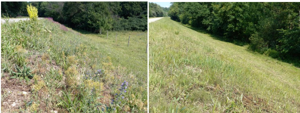
Abbildung 13 und 14: beweideter Teil (links) und gemähter Teil (rechts) des Hochwasserschutzdamms, Mitte Juni, einige Hundert m aus einander.
