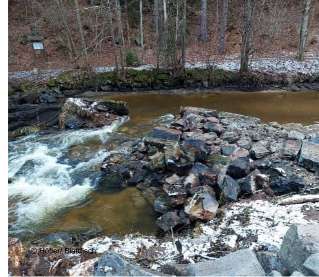
➔ Malsch vor (links) und nach dem Rückbau (rechts)
